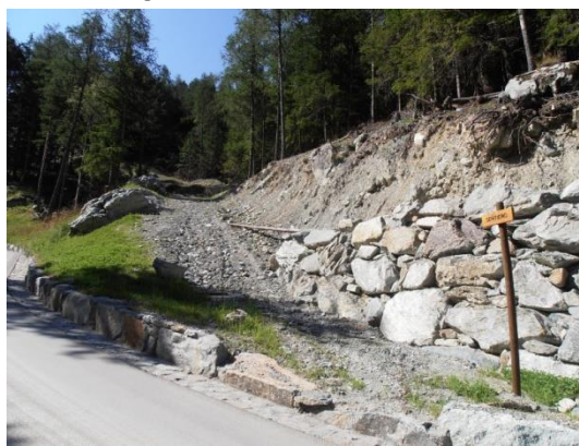
Postumi del lavoro di interrimento della condotta
