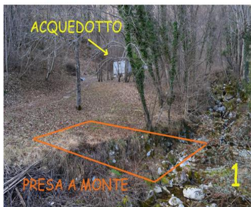
Foto 1 - Presa a monte
