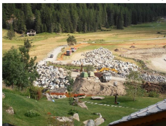
Lavori di scavo a monte, nella piana di Clavalité
